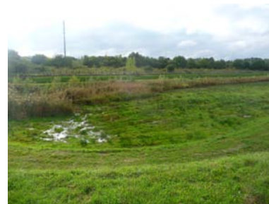
Bassin de rétention
